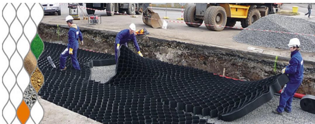
Instalacija saćastih struktura
