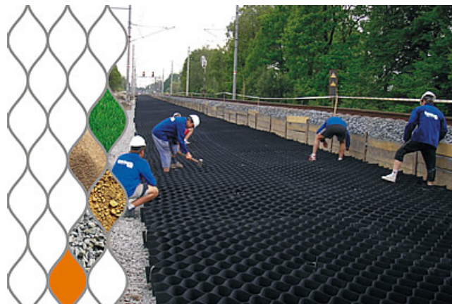
Instalacija saćastih struktura
